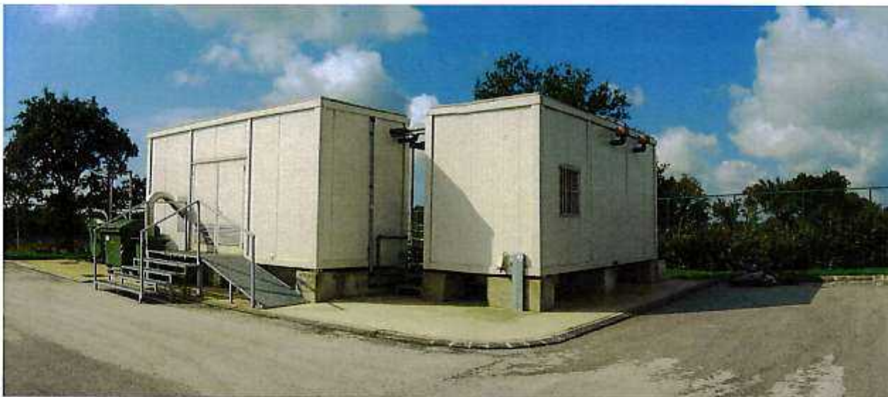
Slika 5. Uređaj za pročišćavanje otpadnih voda Sv. Lovreč
