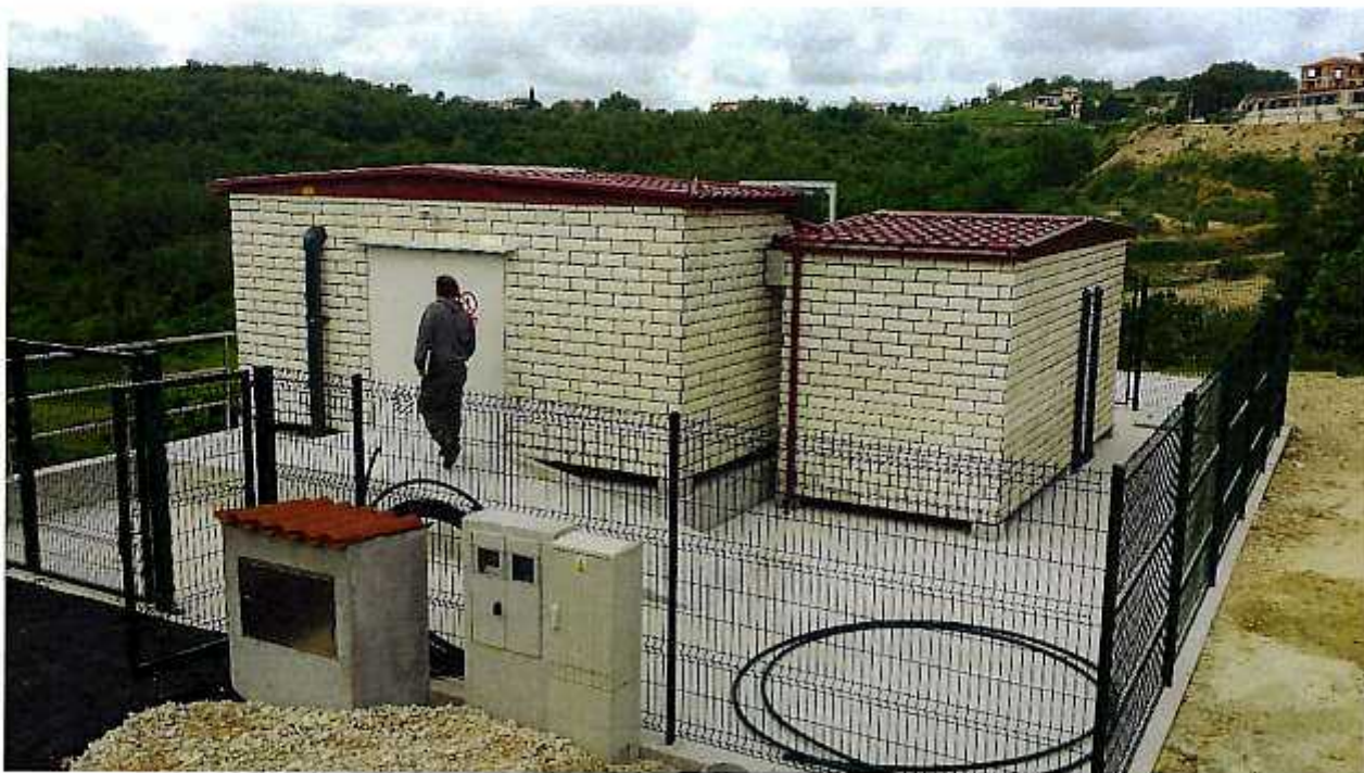
Slika 6. Uređaj za pročišćavanje otpadnih voda Vižinada
