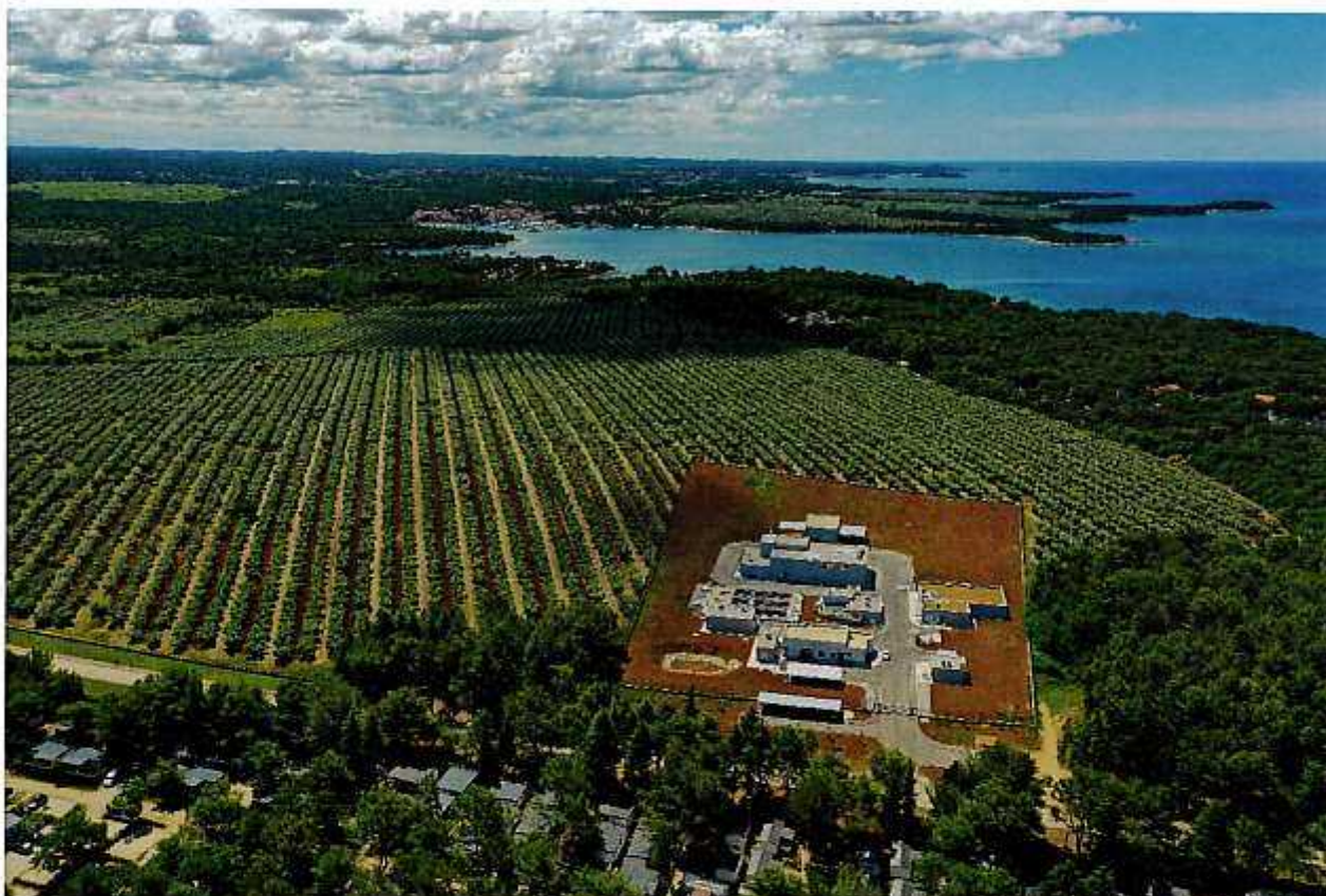
Slika 1. Uređaj za pročišćavanje otpadnih voda Lanterna
