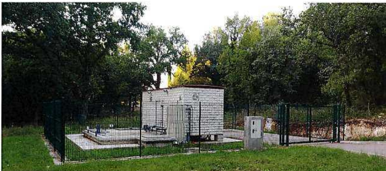
Slika 7. Uređaj za pročišćavanje otpadnih voda Kloštar
